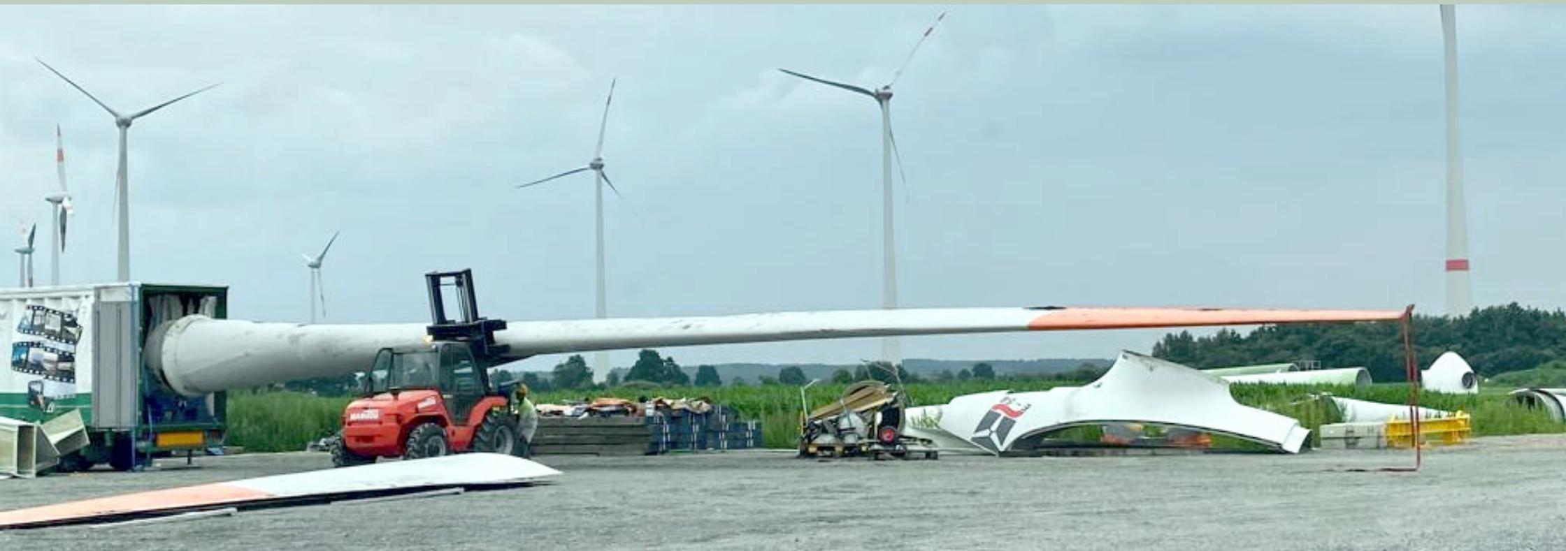
Platzierung des Rotorblattes in die Halterung um den Schneidevorgang zu starten
