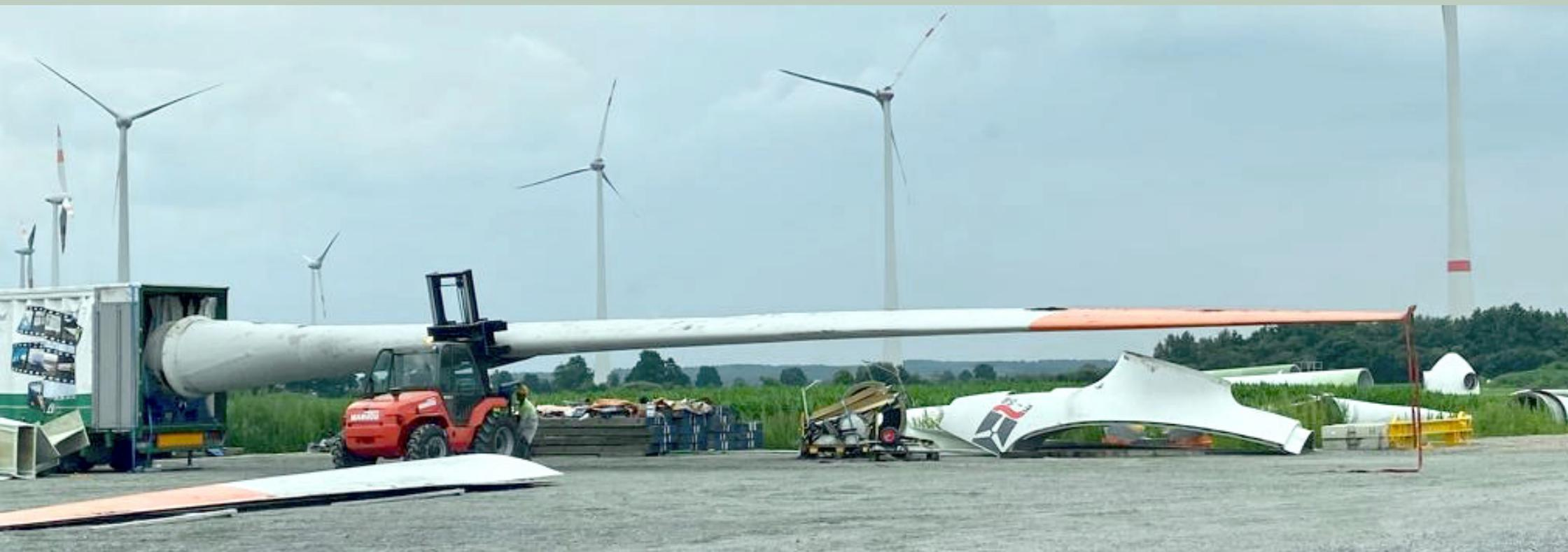
Colocación de pala en soporte para el inicio de la operación en camión aserradero.
